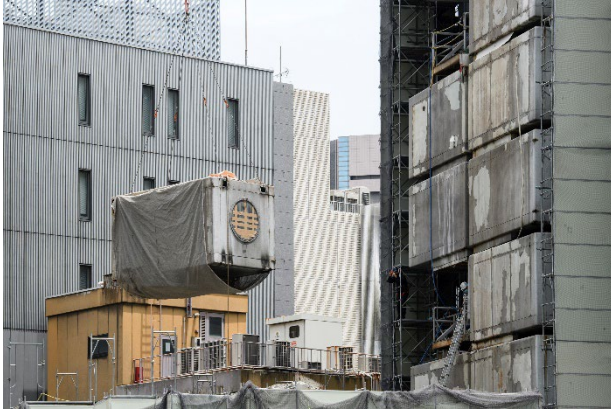
▲解体時クレーンで下ろされるカプセル (撮影：山田新治郎)
