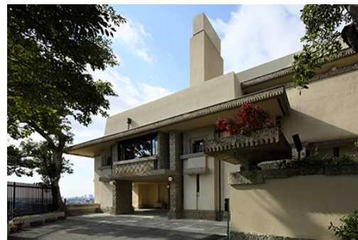
(外観 1階エントランス)
