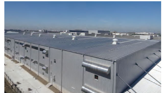
YBMH社(中国) 施工例 屋根66H 外壁806型 物件名:日立物流(天津)第二倉庫新築工事
