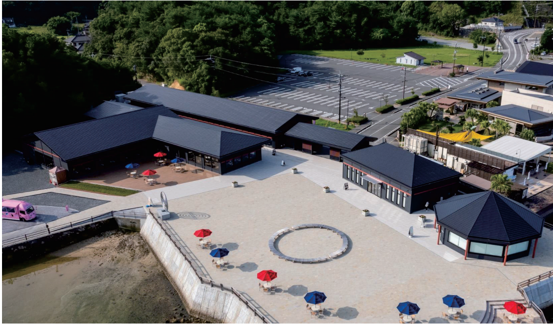
【ヨドルーフ施工例「天草パールガーデン」】
