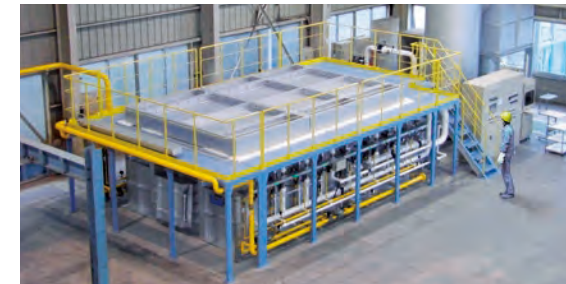
耐火試験装置(大阪工場)
