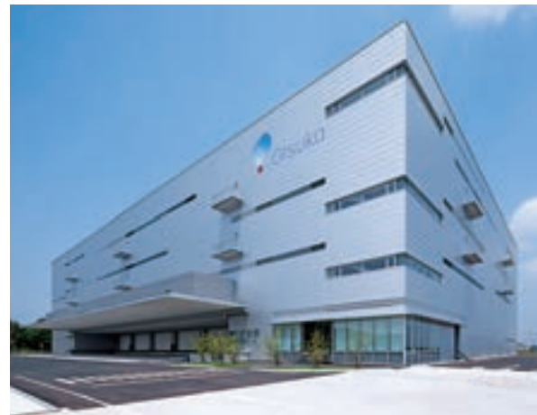
グランウォールを使用した施工事例 大塚倉庫株式会社西日本ロジスティクスセンター
