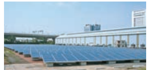
泉大津工場 太陽光発電システム
