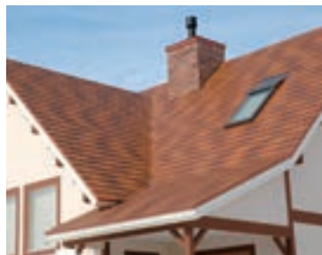
「ハイブリッドグラデーション」(意匠鋼板) 施工例
