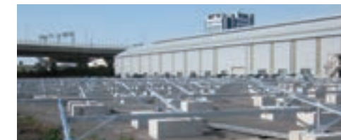
泉大津工場 太陽光発電システム 架台設置状況
