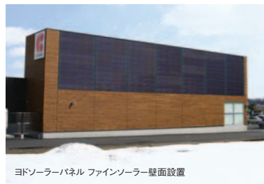
ヨドソーラーパネル ファインソーラー壁面設置
