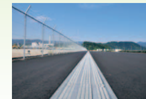
教賀港鞠山南地区 多目的国際ターミナル造成工事
