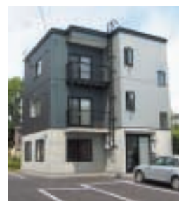
壁材「フレッシュモダン」施工例
