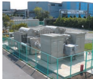
当社 市川工場 特高変電所
