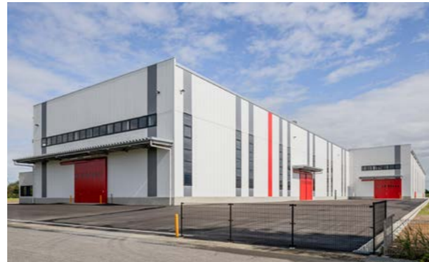
水島鉄工(株) 安田工場
