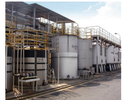
呉工場 表面処理工場廃液処理設備
