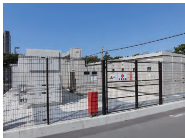
泉大津工場 受電変電設備の更新
