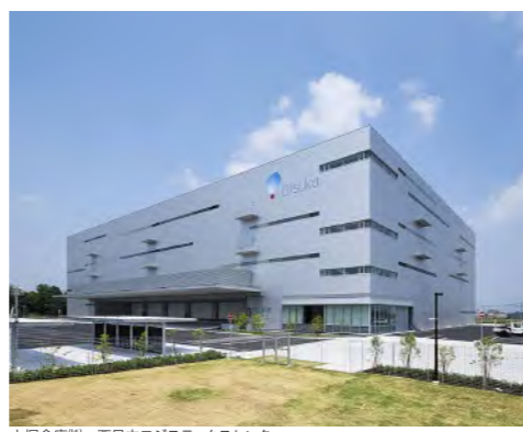
大塚倉庫前 西日本ロジスティクスセンター
