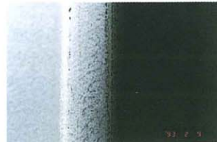
【写真-9】ヨドルーフ166ハゼの『シーマー曲げ部』に発生したアブレーション （注：写真右半分の黒色部は、“背景”でアブレーションとは無関係です）
