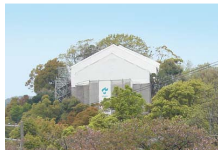
<工事中の当館全景> (足場と素屋根のテントに覆われています)
