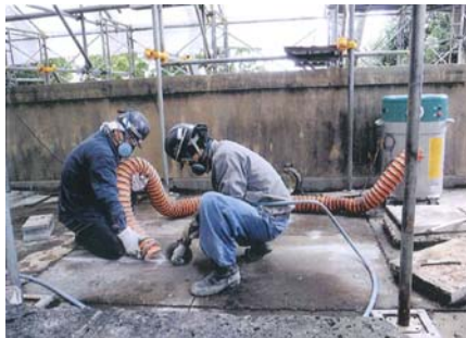
4階屋上での防水層の除去作業
